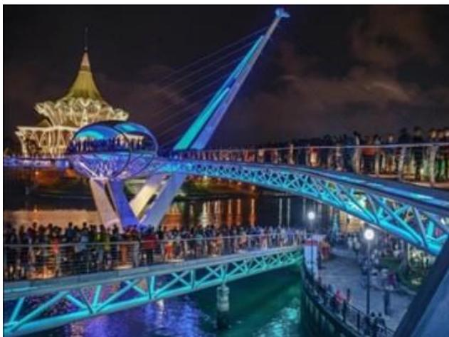
ダルルハナ橋は、2017年11月にオープンした美しい歩道橋です。クチンの住民は、常に「ボットタンバン」または「水上タクシー」でサラワク川を渡らなければなりませんでした。これで、人口と観光客は、橋を渡って南からクチンの北に渡ることができます。橋はその特別な形のために際立っています。まっすぐな橋ではなく、陰と陽のサインに似たS字型の歩道橋です。橋の長さは336メートルで、高さ45メートルの2本のケーブルで支えられています。鋼鉄柱は48度の角度で外側に面しています。それらは反対の方向に立っており、それはサラワクに住む文化の間のバランスを象徴しています。長いS字型の橋はBidayuhコミ
